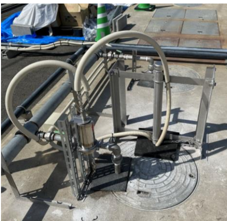
ATコンポ 水中ポンプタイプ設置
