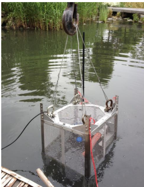
ATコンポ 水中ポンプタイプ設置作業
