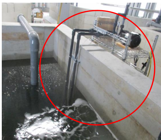
ATコンポ 陸上ポンプタイプ稼働状況
