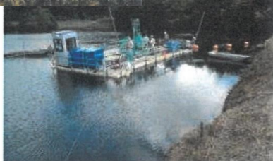
ポンプによる浚渫作業
