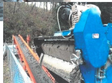
フィルタプレスとベルトプレスによる脱水作業
