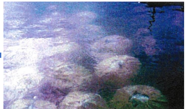
海中に投入されたCAS-42入りフレコンバックは、速やかに固化します
