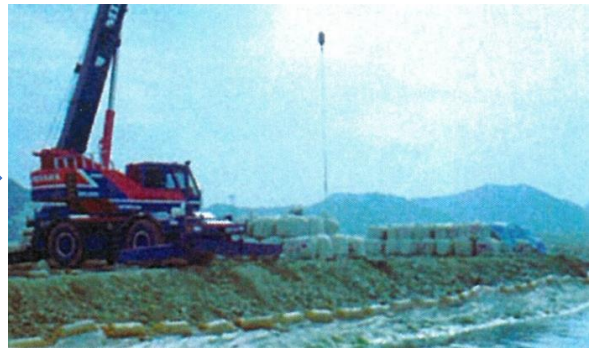
フレコンバックを海中に投入
