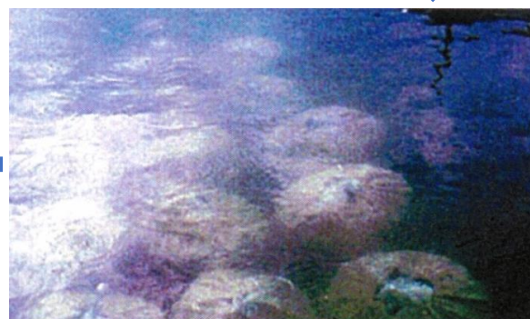
海中に投入されたCAS-42入りフレコンバックは、速やかに固化します
