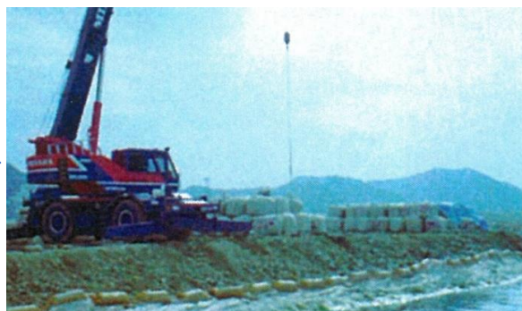
フレコンバックを海中に投入
